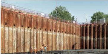
Spunsslidsevæg, Kanalvej, Lyngby
