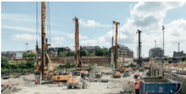
Borede pæle, Nordhavnsvej, København
